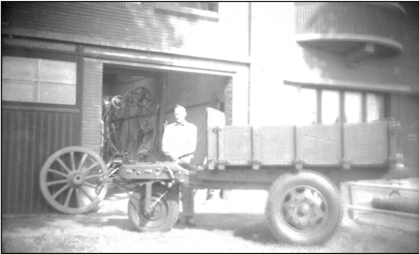
Fig. 3 - Wagenmaker Alfons Bogaert uit Waardamme, met zijn eerste kar op 'luchtbanden', jaren '50. In de wagenmakerij zie je dat de aandrijving van de machines gebeurde met één elektrische motor via een as waarop meerdere aandrijfwielen waren aangebracht. Een aandrijfband deed de machine (lintzaag, boor, frees, ...) draaien.
