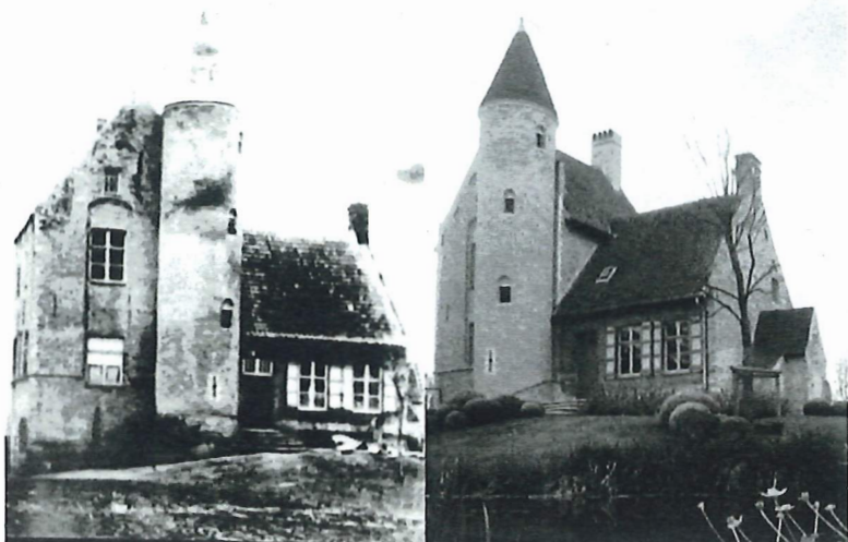
VOOR en NA de restauratie
