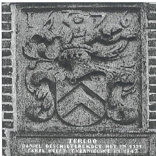
Steen in arduin met wapenschild van de familie de Schietere, ingemetseld in de zijgevel van de woning van het neerhof Ter Loo
