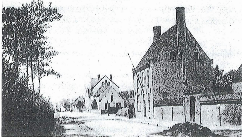
Schoolpoortje en woonhuis van de Broeders van O.L.V. van Lourdes in de Stationsstraat. (Uit: BONDUEL L. & Cappon G., Wandelen in Loppems verleden , Uitg. Flandria Nostra)
