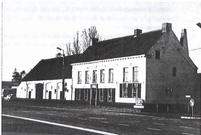
Boven: De drie Zwaluwen in Aartrijke, beschermd bij K.B. van 8 september 1971. Onder: De Heidelberg in Loppem, beschermd bij M.B. van 12 januari 1987.
