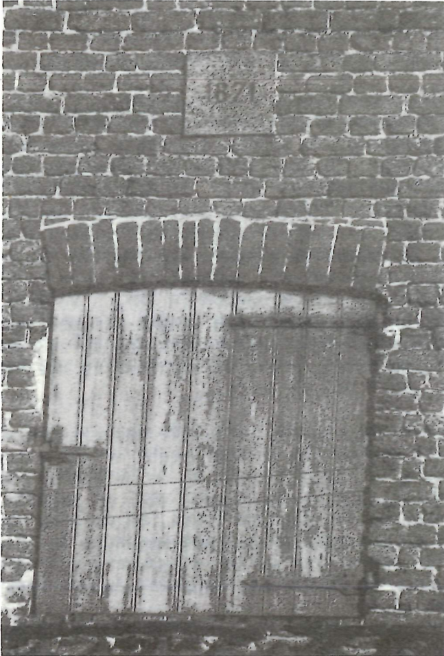
Detailopname van de westzijde van de graan- schuur met ingemetselde datumsteen.
